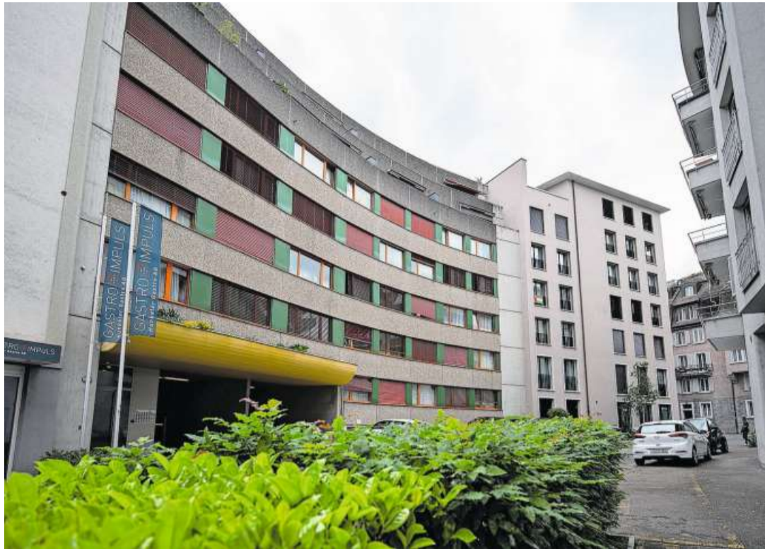
Die GSW plant Kernsanierung der Liegenschaft am Grimselweg 11. Bild: Dominik Wunderli (Luzern, 16. 5. 2024)
