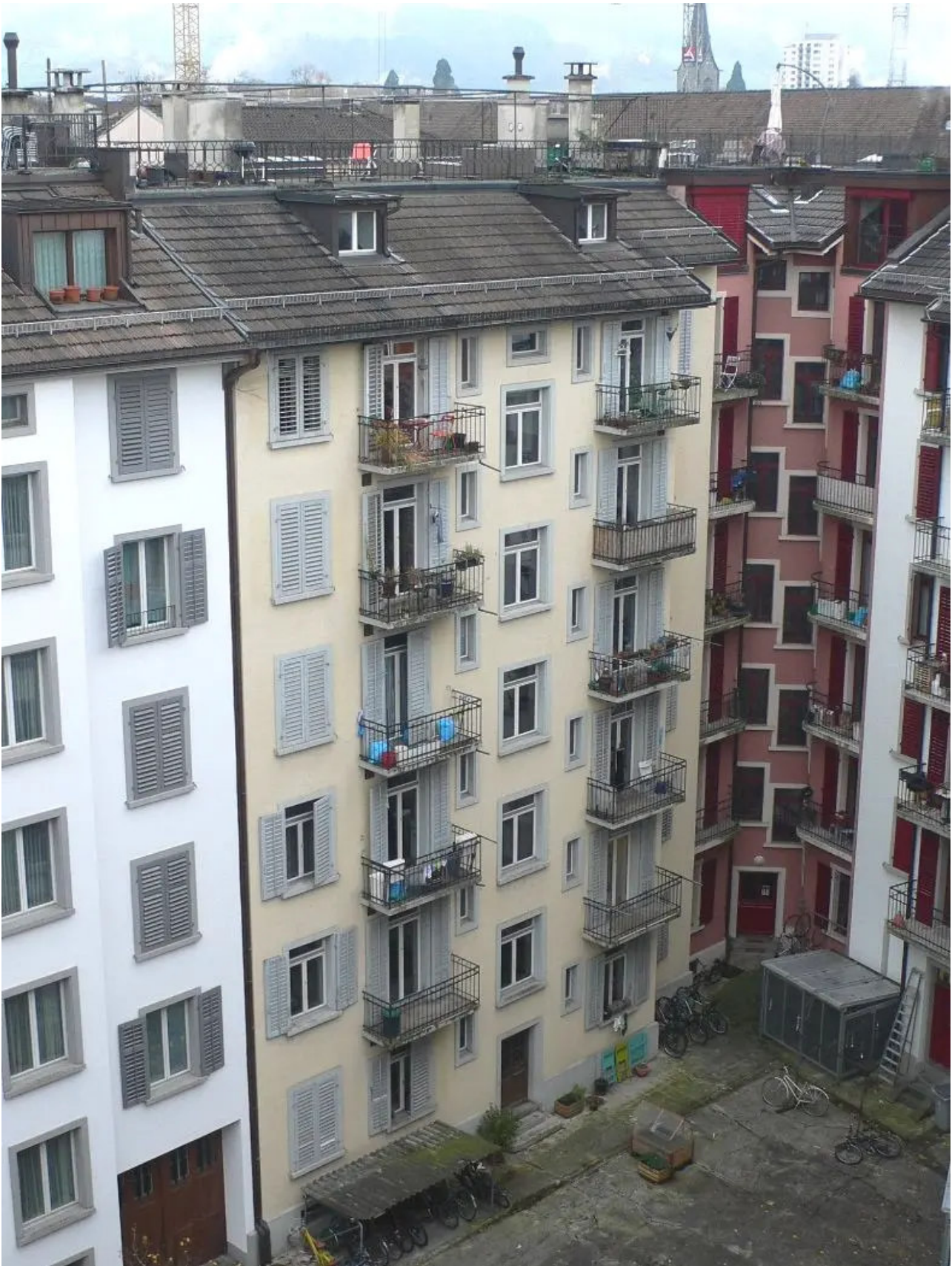
Auch das blassgelbe Gebäude an der Mythenstrasse 8 wird voraussichtlich 2019 saniert. (Bild: PD)
