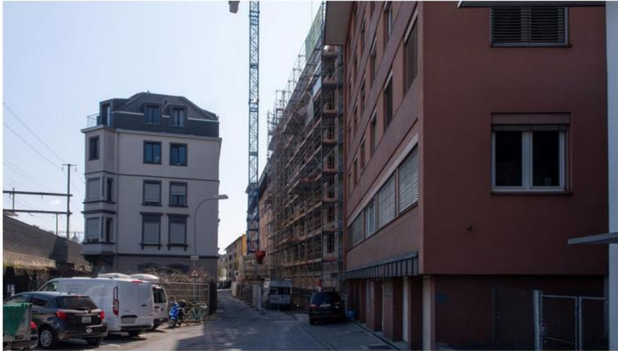
An der Baselstrasse 80 entstehen 34 günstige Wohnungen. (Bild: GSW Luzern, Sibylle Kathriner)
